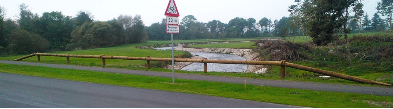
Figur 2: Modelbillede af typen af træautoværn.
