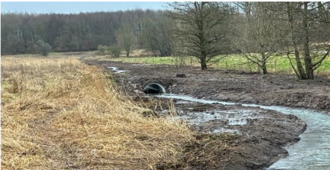
Figur 3: Eksempel på rørbro i terrænnært vandløb.
