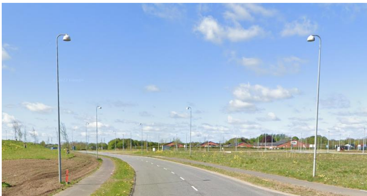
Prinsessens Kvarter – 8 m koniske master placeret dobbelt-sidigt i bagkant cykelsti – Philips Københavner armatur er monteret på buet arm.
