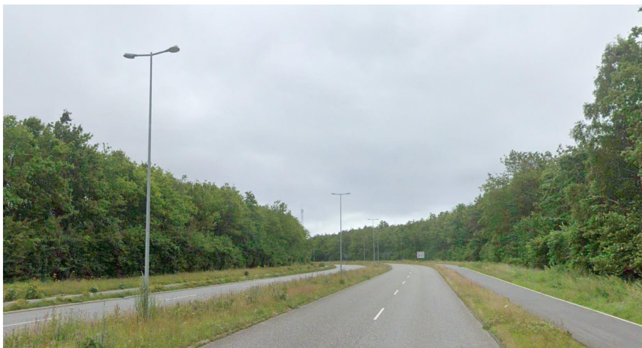
Trafikvej, By, Vestre Ringvej – 9 m koniske master i midterhelle – Focus Peak armaturer monteret på arm.
