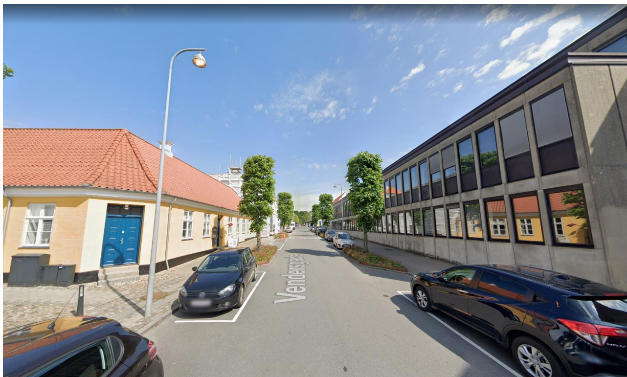
Boligvej indenfor Volden – 8 m konisk galvaniseret mast med Københavner, masteplacering i forkant fortov.
