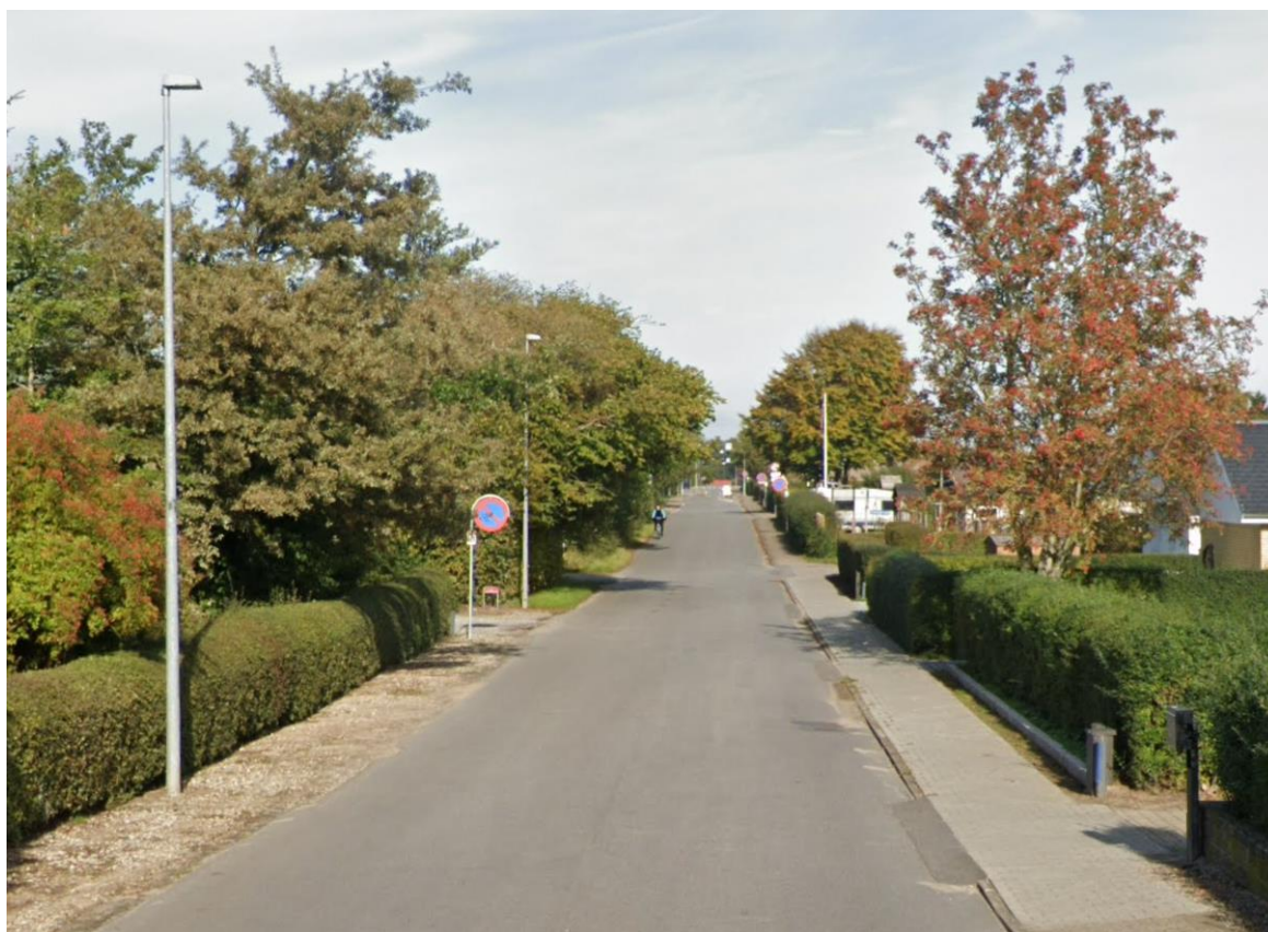
Krogsagervej – 7 m koniske master placeret i bagkant fortov – Thorn Civiteq armatur er topmonteret
