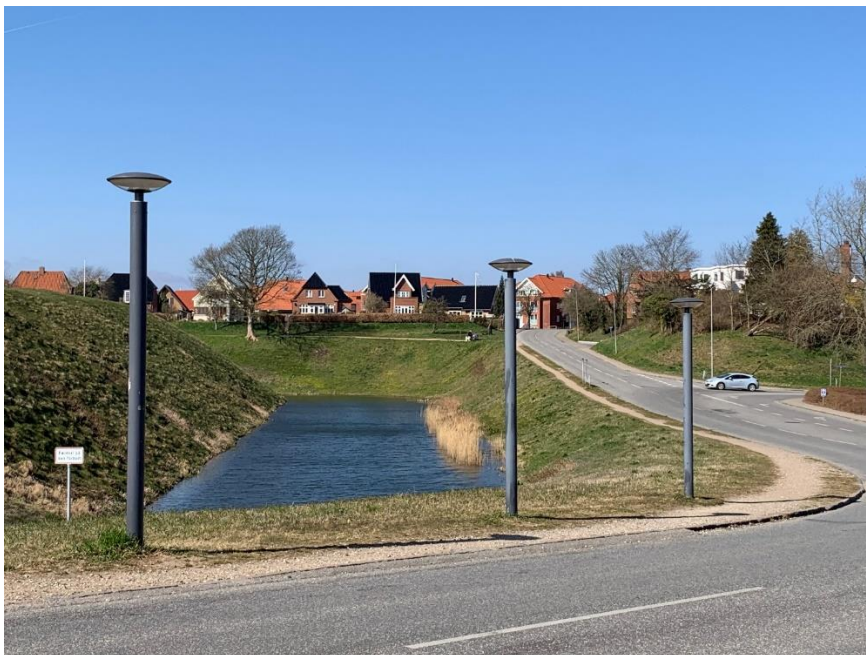
Kongens Port, Focus Space monteret på eksisterende Helios master med specialstuds og 2 stk. afstandsringe.
