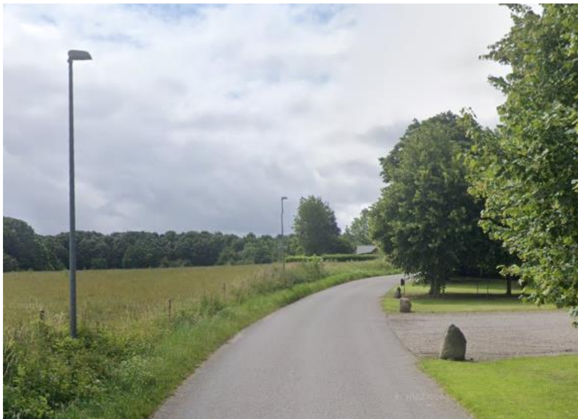
Forbindelsesvej, Land, Vejlbvej – 6 m koniske master med Thorn Civiteq topmonteret.
