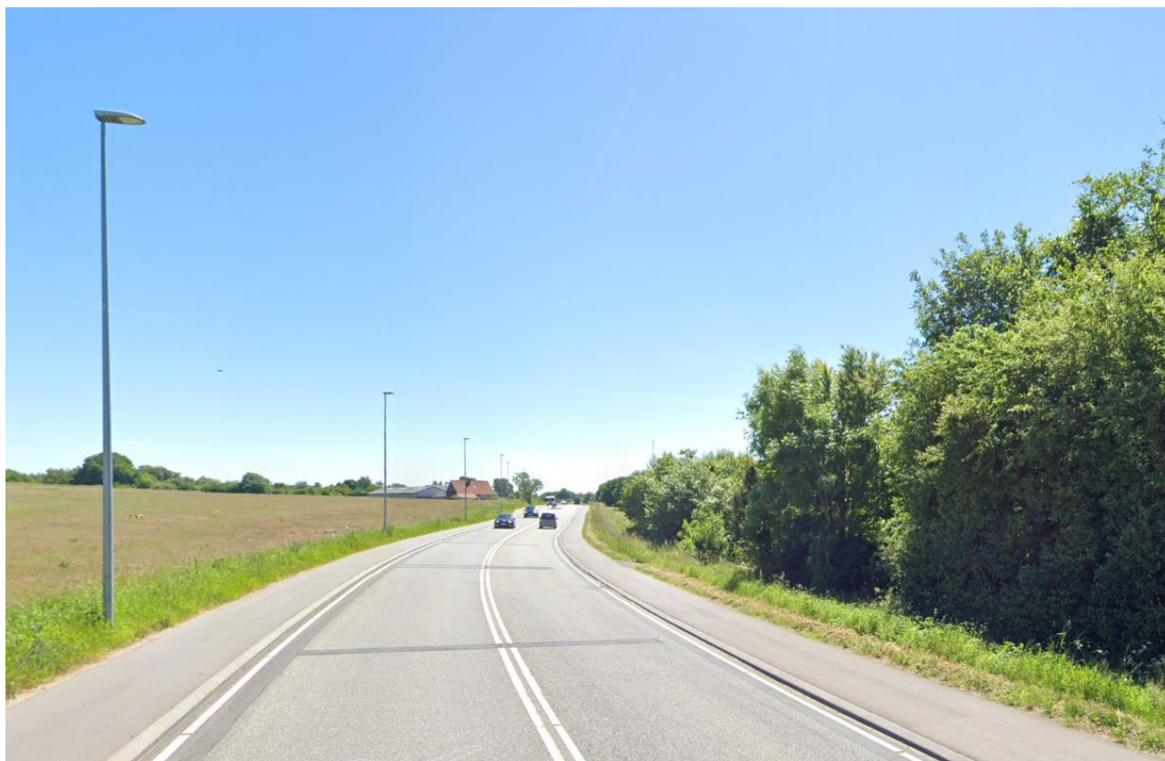
Trafikvej, Land, Kolding Landevej – 9 m koniske master i bagkant cykelsti – Iridium armatur topmonteret
