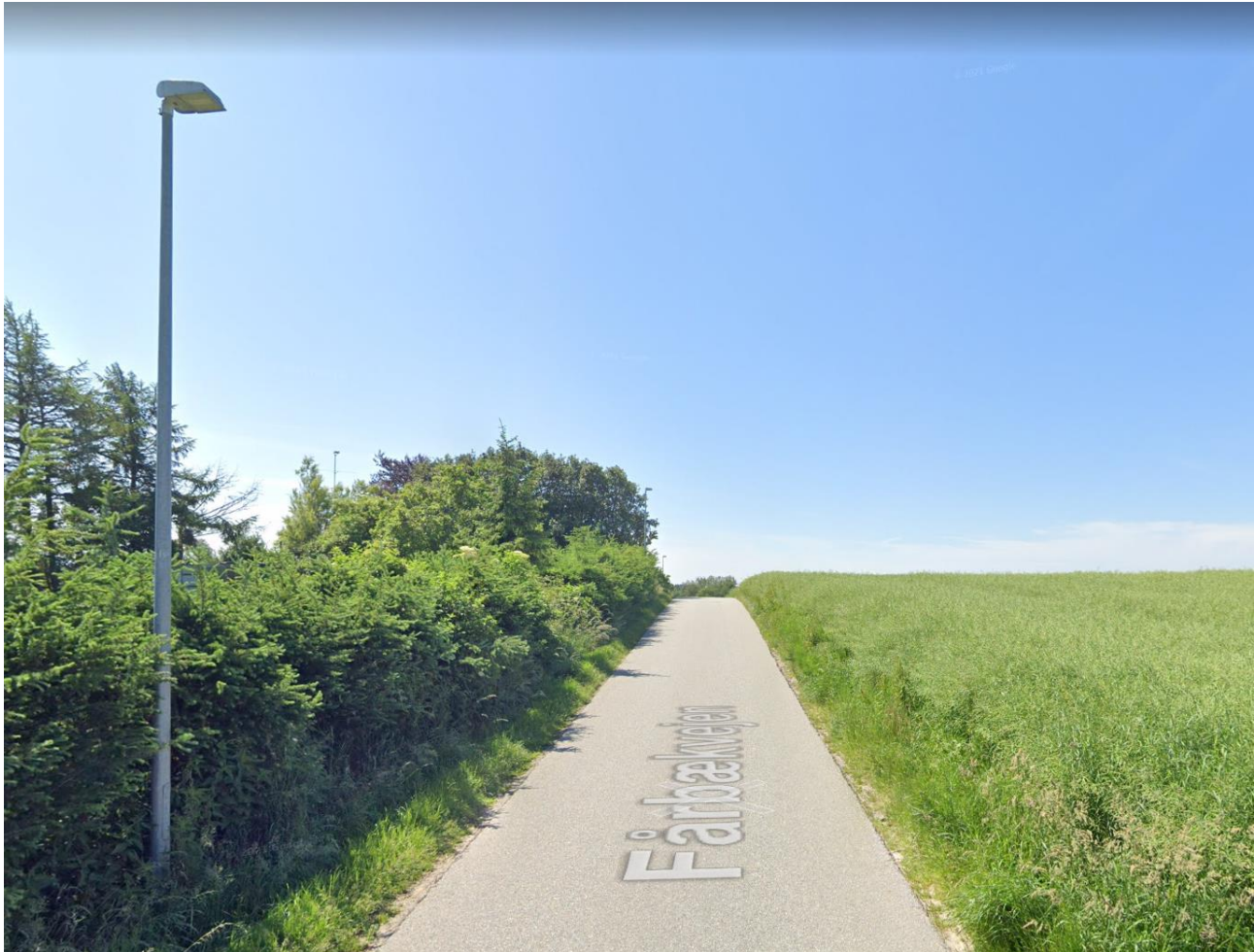
Lokalvej, Land, Fårbækvej – 6 m koniske master med Thorn Civiteq topmonteret.
