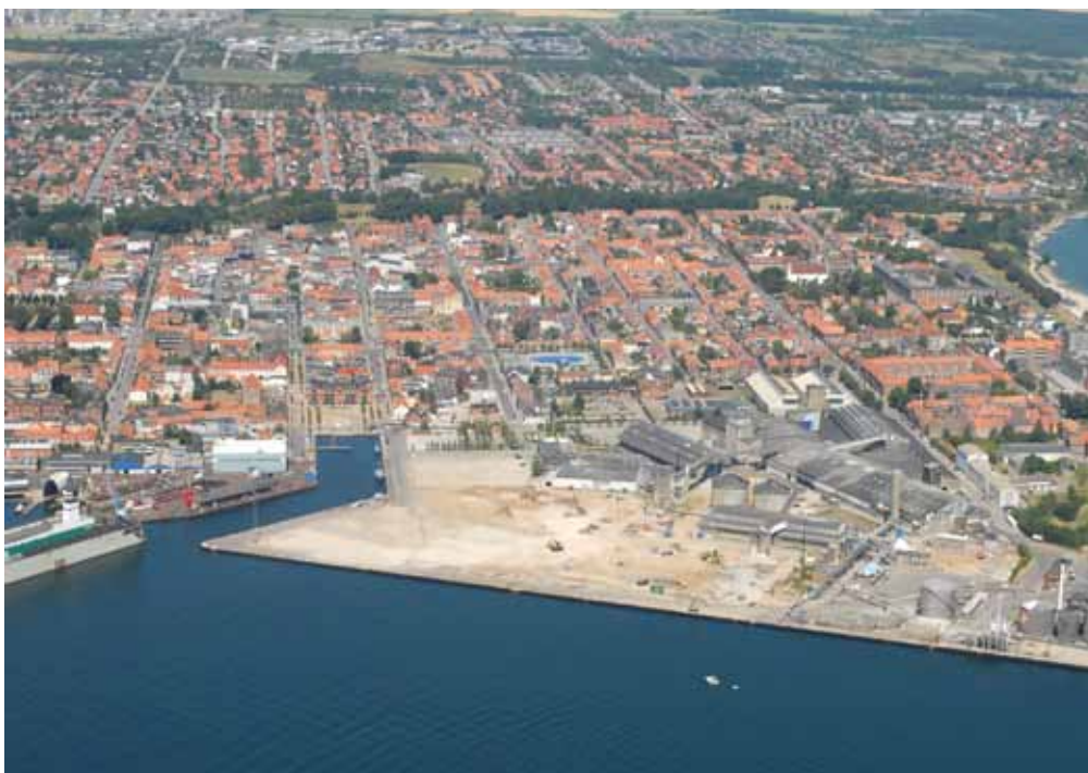
Luftfoto af det samlede byudviklingsområde hvor de tidligere industribygninger er under nedrivning
