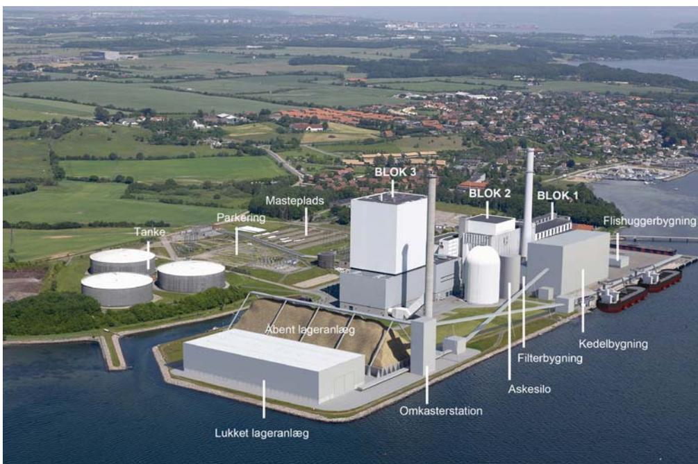
På visualiseringen ses Skærbækværket ved en fuld udbygning af alle anlæg. Forrest ses lagerområdet til oplagring af biomassebrændsler, og mellem blok 2 og kajkanten er vist de forskellige anlæg til håndtering af biomassen. Biomassen transporteres via transportbånd, der løber mellem anlæggene samt langs kajkanten, hvor biomassen losses og lastes på skibe.
