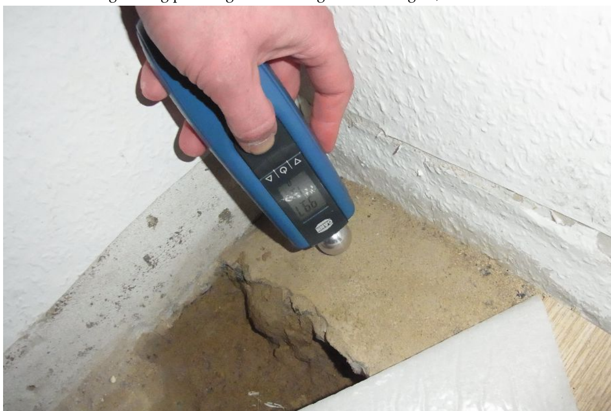
Fugtmåling på 99 digits i terrændæk under gulv, soveværelse
