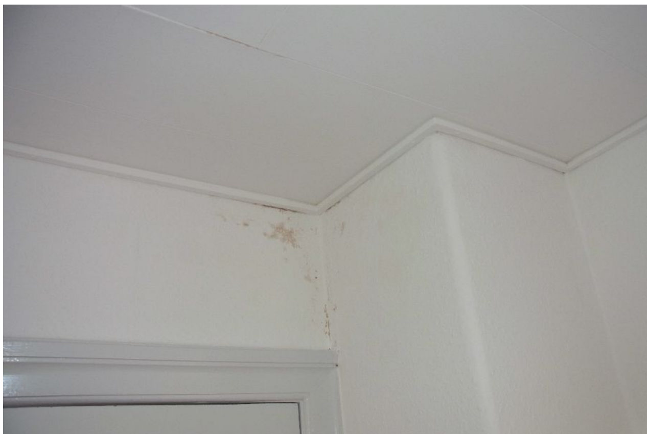
Fugtskade omkring skorsten, værelse, 1. sal – Aftrykssted nr. 1
