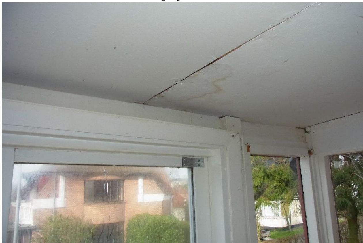
Fugtskade i udestue
