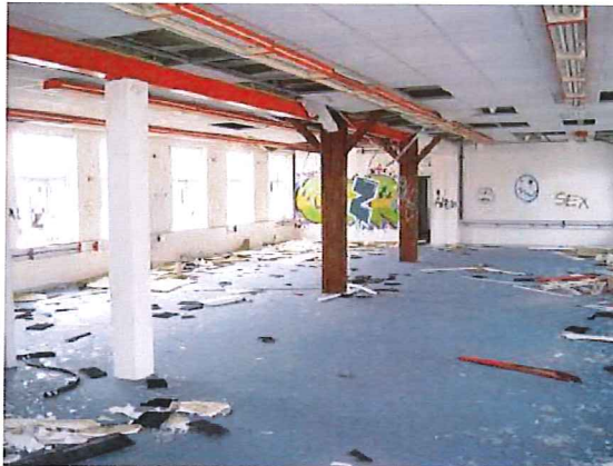
Bygning C set indefra, 2. etagen.
