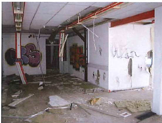
Bygning C set indefra, 1. etagen.
