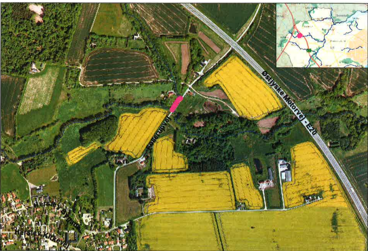
Figur 12. Genåbning af rørlagt strækning i tilløb til Gammelby Mølleå
