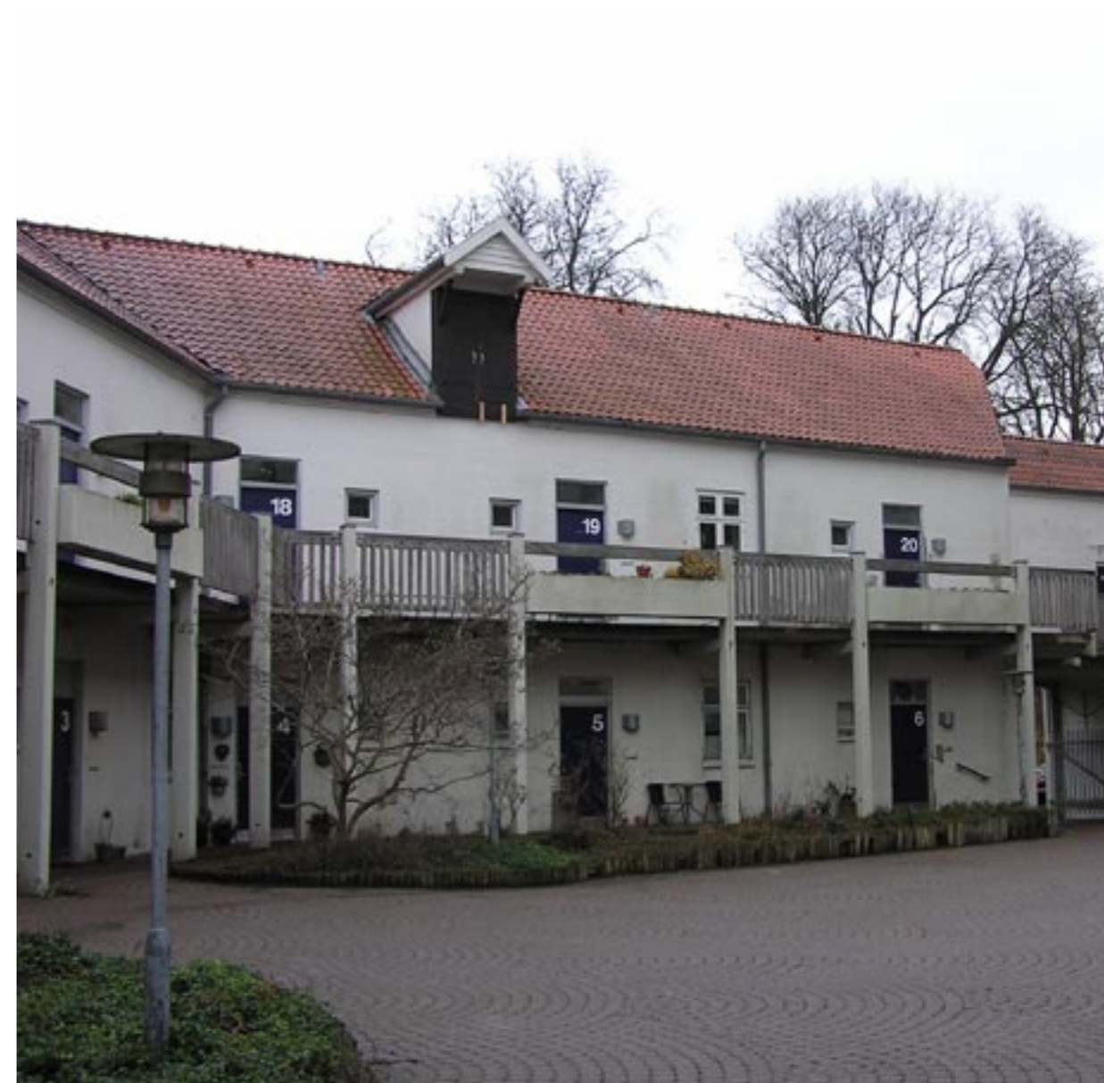
Sydøstfacade mod gårdrum
