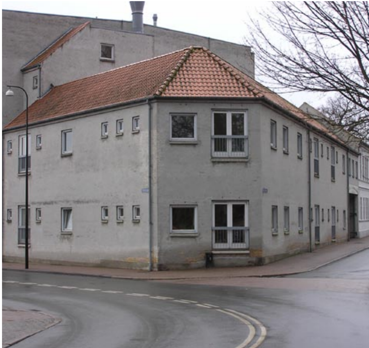
Øst og nordøstfacade mod gade
