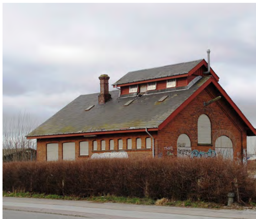
Bygningens ydre er bevaret fuldstændig som oprindeligt.
