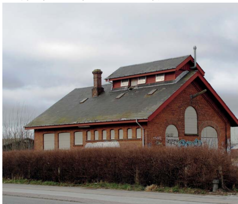
Bygningens ydre er bevaret fuldstændig som oprindeligt.
