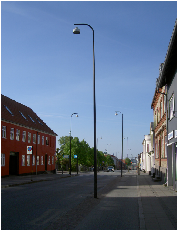
Norgesgade med Københavnerarmatur på sort konisk mast med buet arm
