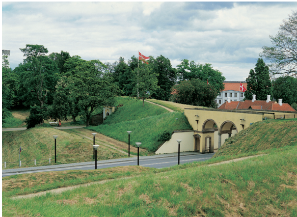
Voldanlægget der om aftenen er oplyst, så voldens dramatik også opleves der
