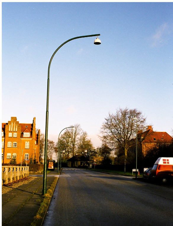
Grønmaledede koniske master med Københavner armatur
