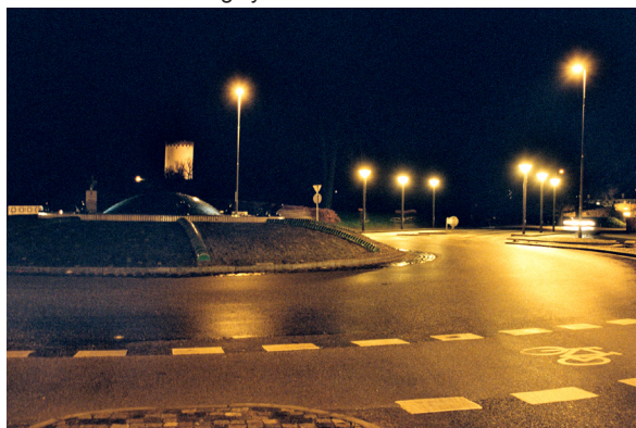
Frederik d. 3's plads med de 6 Helios-lamper
