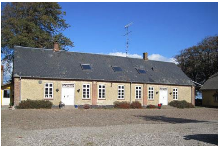
Bevaringsværdigt stuehus ved Gl. Ribevej 19.
