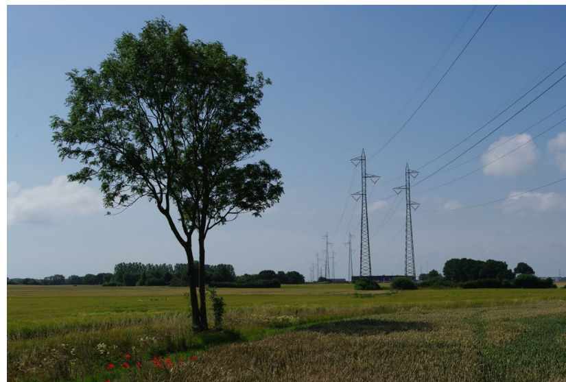
Området gennemskæres af transmissionsledninger.
