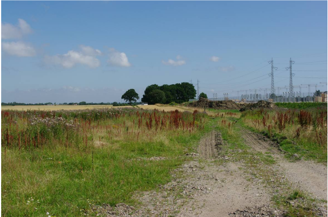
Eksisterende forhold set fra markvej ved Prinsessens Kvarter, hvor EnerginetDK netop har opført en ny transformatorstation, der ses til højre i billedet.
