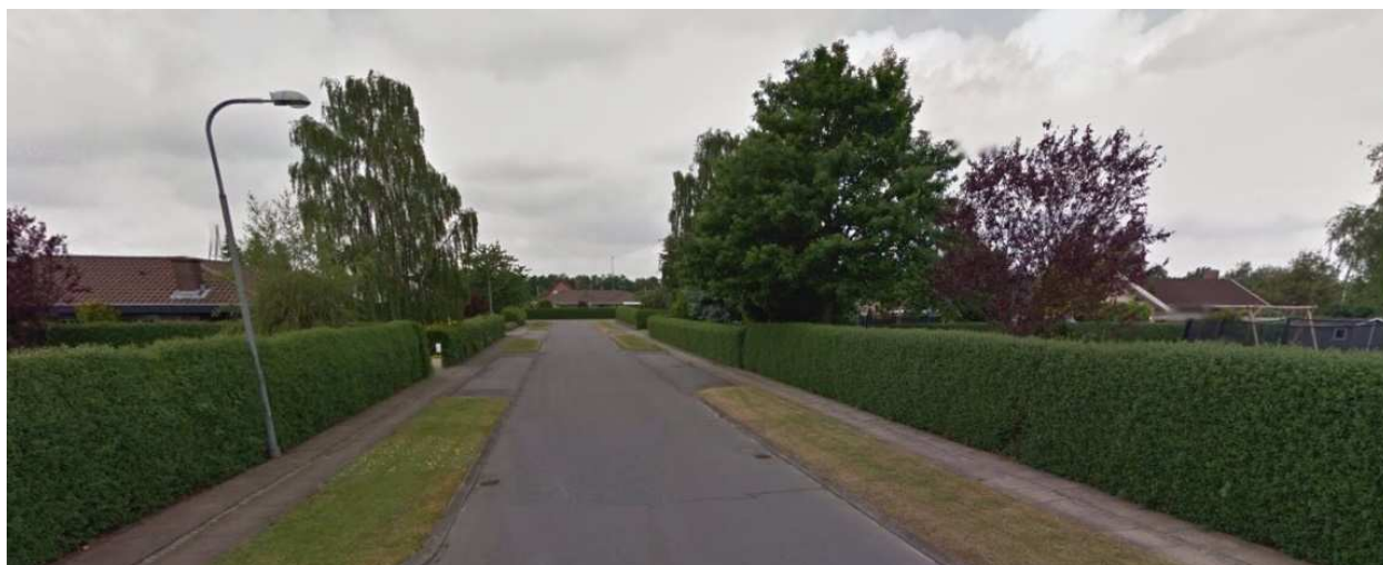
Boligvej med ældre vejarmaturer, Pallasvænget
