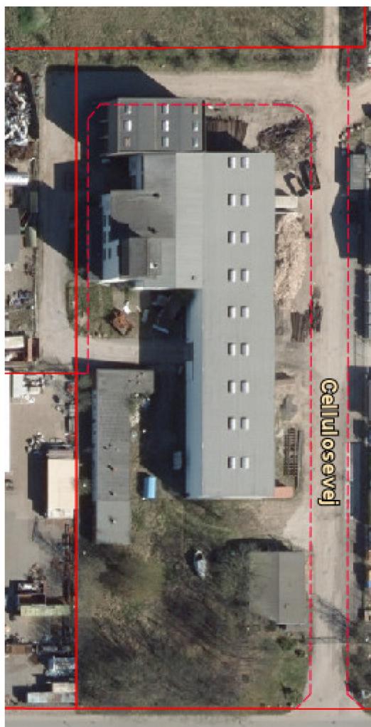
Oversigt over produktionsbygningen på Nordre Kobbelvej 19.
