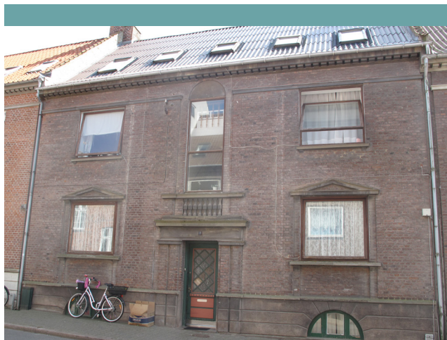
Falstersgade 6 før renovering
