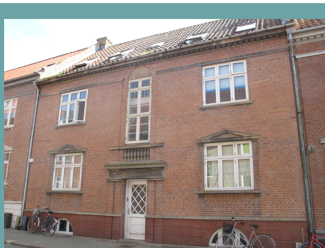
Falstersgade 14 efter afrensning og renovering
