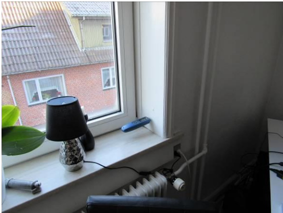
#31 Stue – Måling af vest-facade. Højre del af vinduespartiet – vindueslysning.
