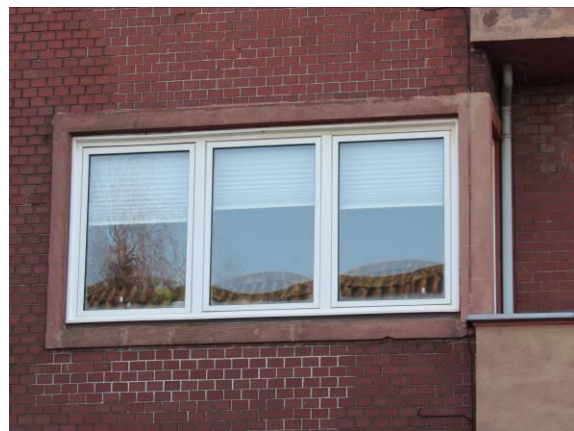
#4 Nærfoto af beton-”ramme” omkring vinduer.
