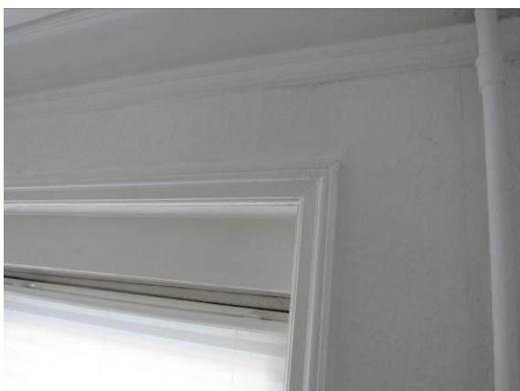
#29 Stue – Måling af vest-facade. Højre del af vinduespartiet.
