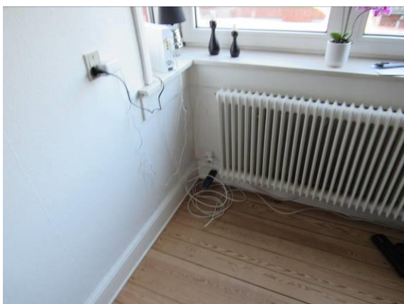
#39 Stue - Måling af vest-facade. Under vinduesparti.
