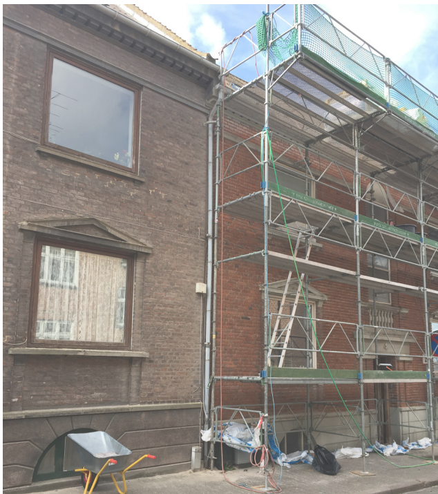
Renovering af byggeforeningshus i Falstersgade 4
