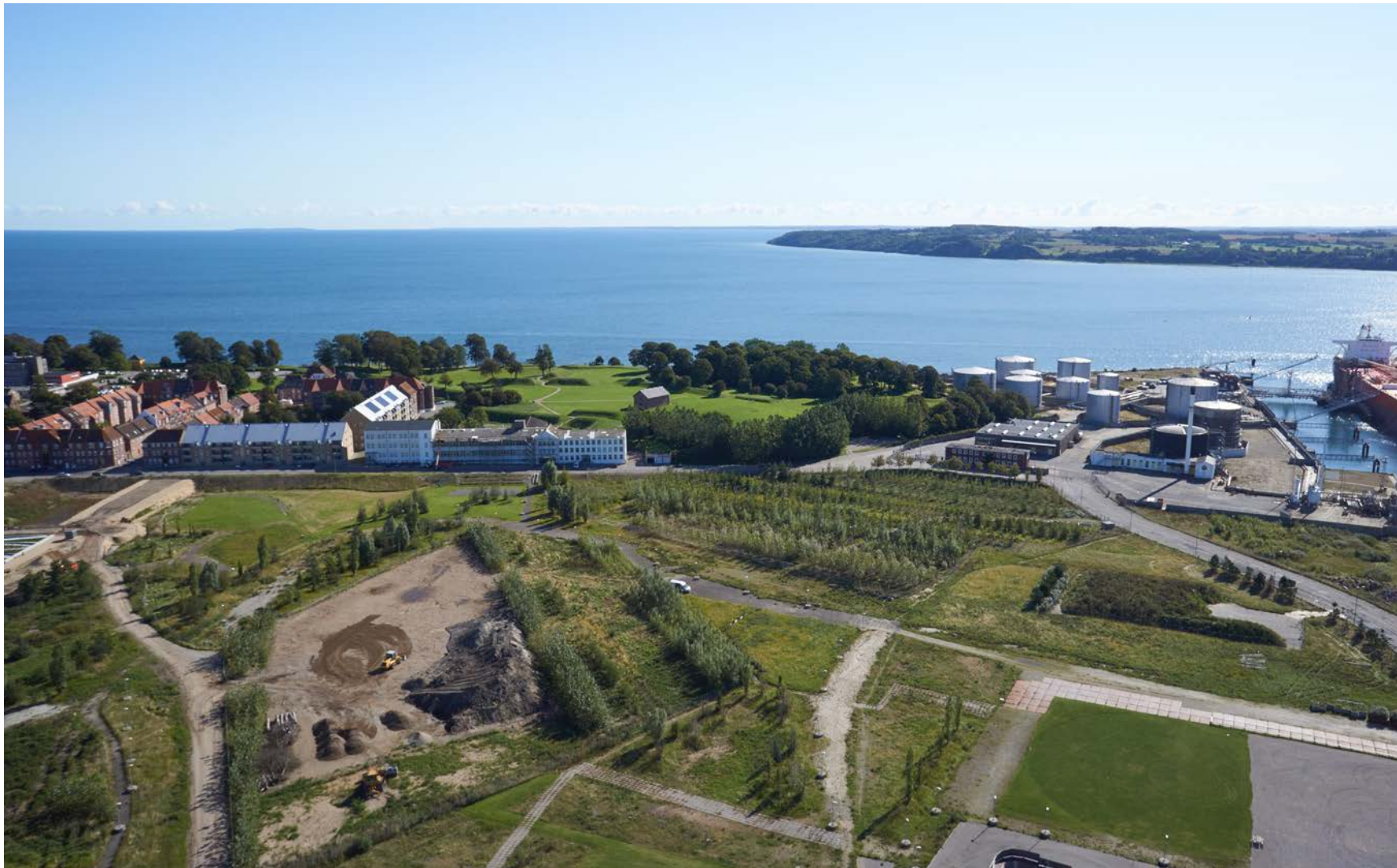
Luftfoto over lokalplanområdet. Kongensgade og den eksisterende bybygelse ses bagerst i billedet. Det ses at Kongensgade og den nyanlagte vej til venstre i billedet ligger i en væsentligt højere kote end lokalplanområdet. Derfor modelleres terrænet i lokalplanområdet så det tilpasses den nye vej og Kongensgade, men således at terrænet falder til omkring kote 2,5 mod kajkanten mod Lillebælt. (Luftfoto fra september 2015)
