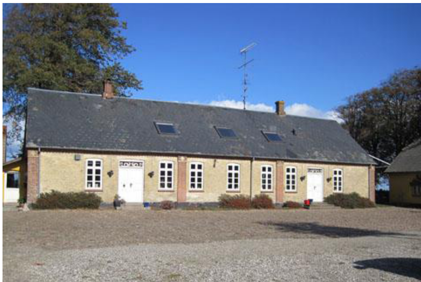
Bevaringsværdigt stuehus ved Gl. Ribevej 19.
