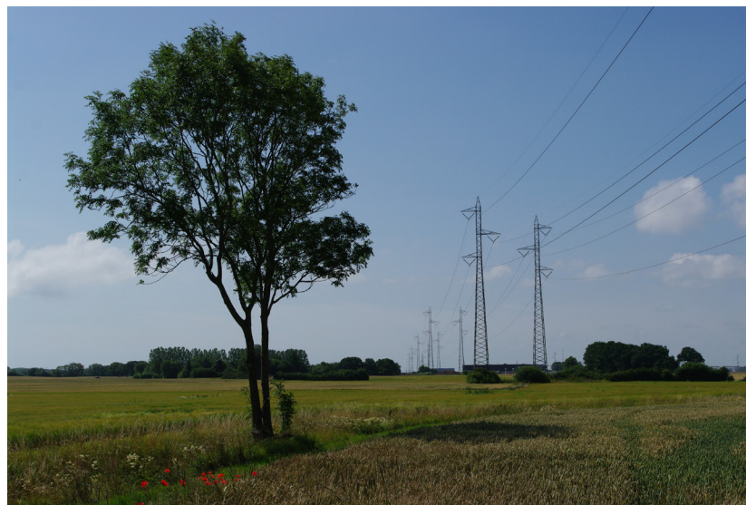
Området gennemskæres af transmissionsledninger.
