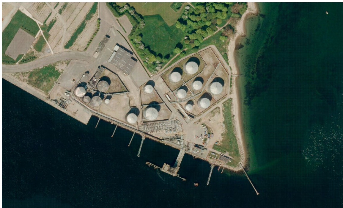
Figur 10. Luffoto over anlægget fra 2012.
