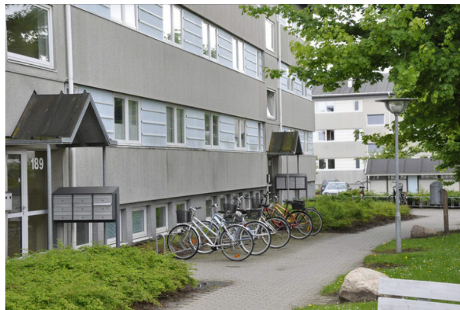
Etageboliger i Skanseparken
