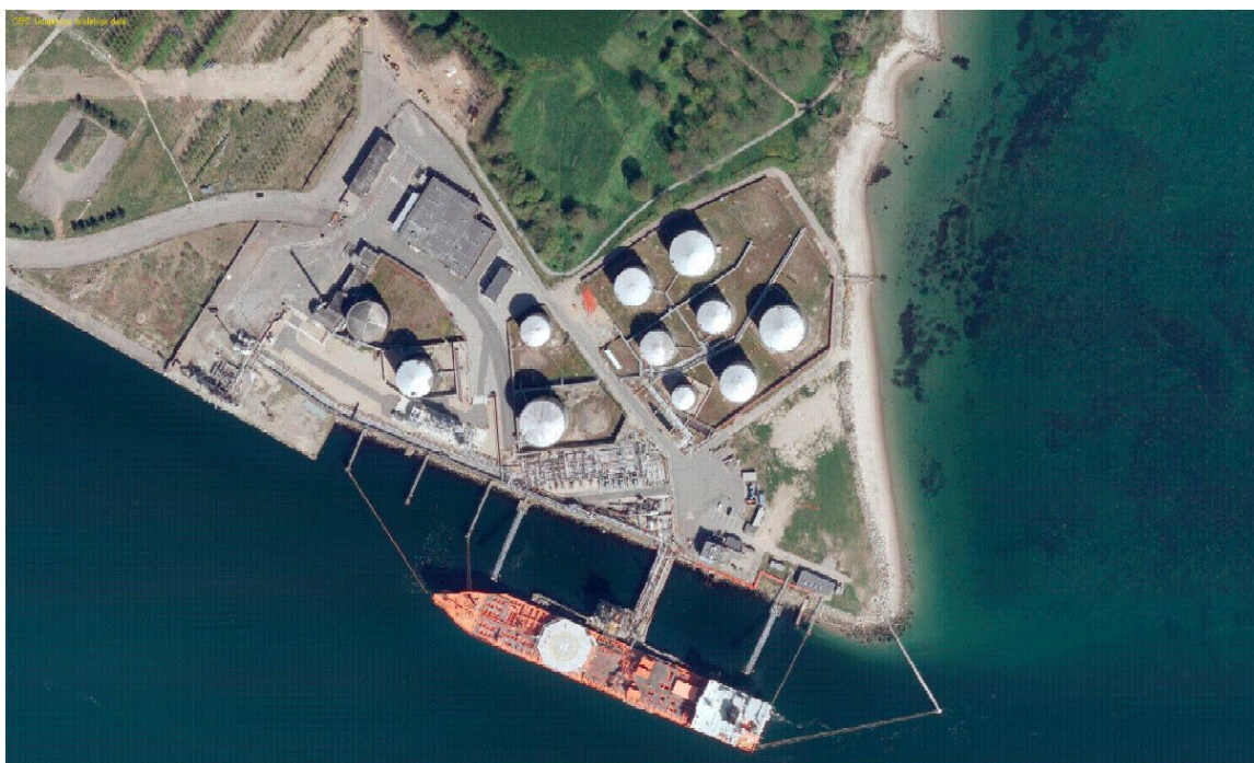
Figur 11. Luffoto herover viser situationen i 2018 efter flere tankanlæg er fjernet, og VRU 2 anlægget er etableret.
