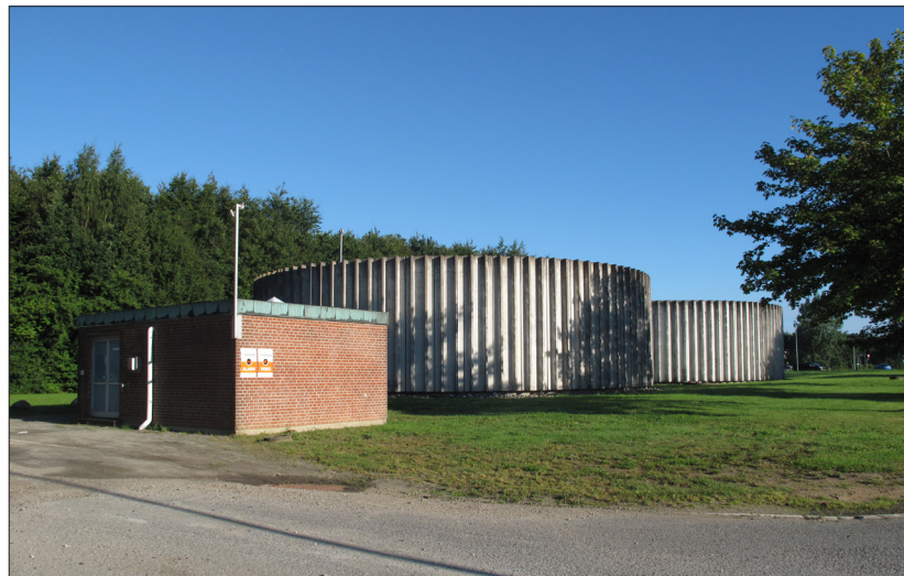
Vandbeholdere ved Egeskovvej
