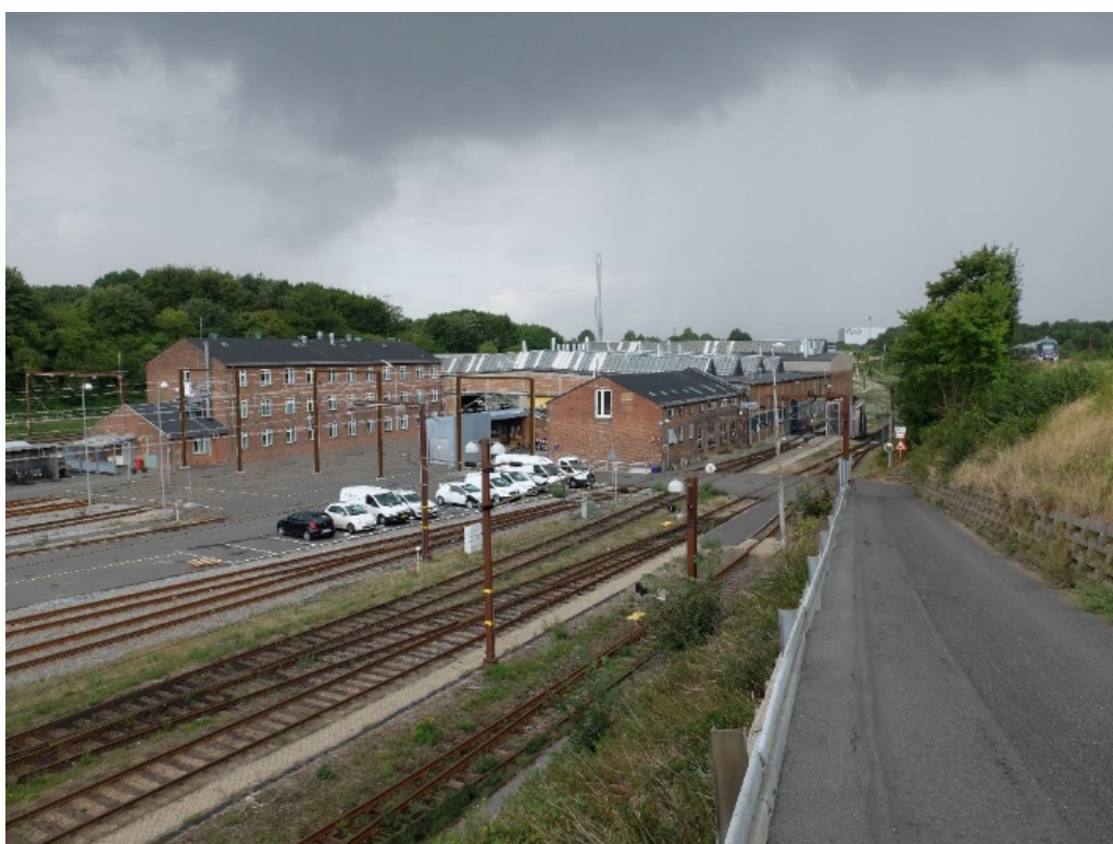
Figur 6-6 Fotostandpunkt 3, Værksted fra Egumvej. Øverst ses før-situationen og nederst ses eftersituationen, med det udbyggede værksted. Dog vil der ifølge lokalplanen kunne opføres yderligere ca. 3.000 m 2 bebyggelse nord og syd for værkstedet, bl.a. mellem de to længer med en højde på op til 14 m, i stedet for de viste 12 m.
