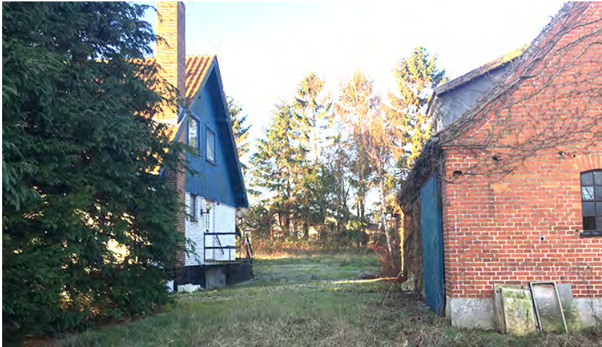
Fotoet viser den eksisterende bebyggelse i lokalplanområdet.
