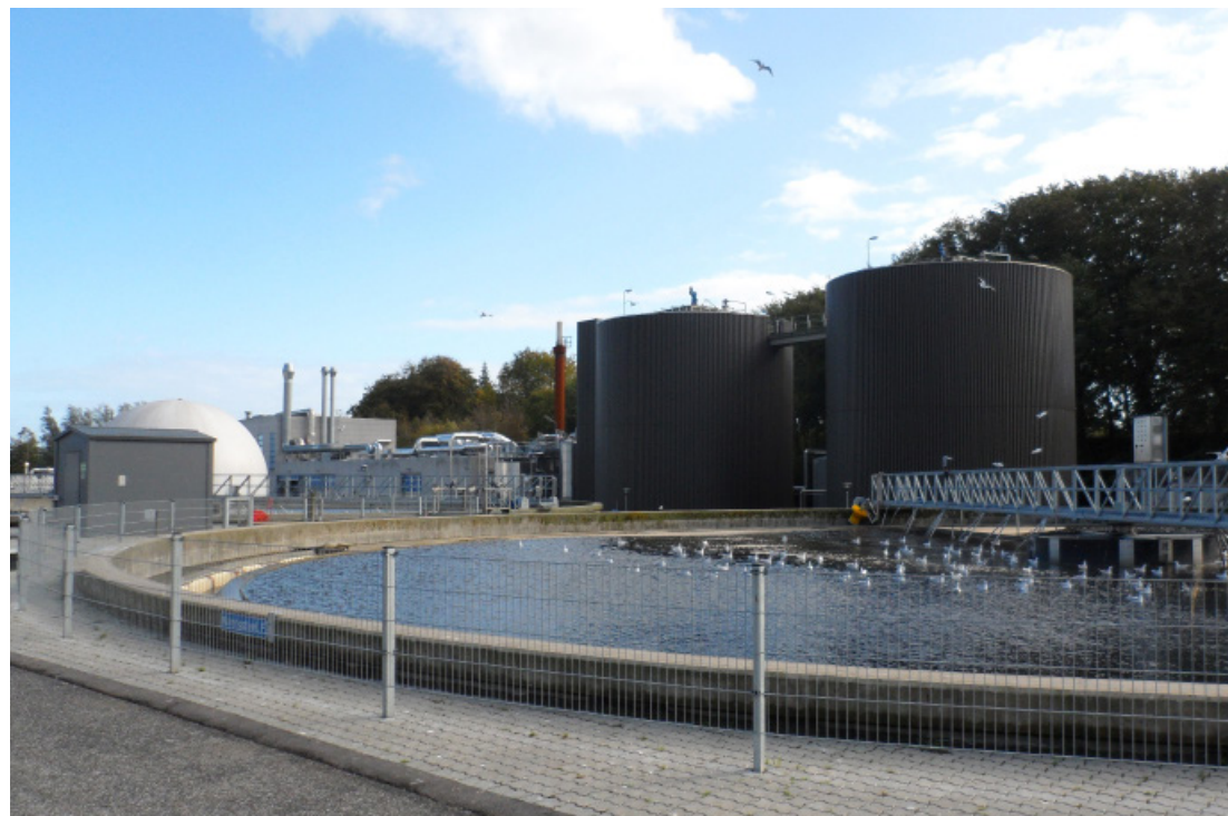
Foto af det eksisterende renseanlæg med bassiner, rådnetårne og andre tekniske anlæg. I baggrunden ses høj, skærmende skovmæssig beplantning.
