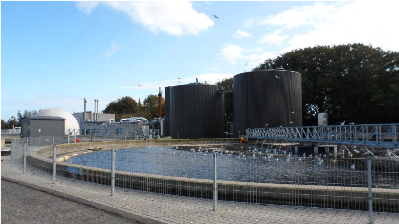
Foto af det eksisterende renseanlæg med bassiner, rådnetårne og andre tekniske anlæg. I baggrunden ses høj, skærmende skovmæssig beplantning.
