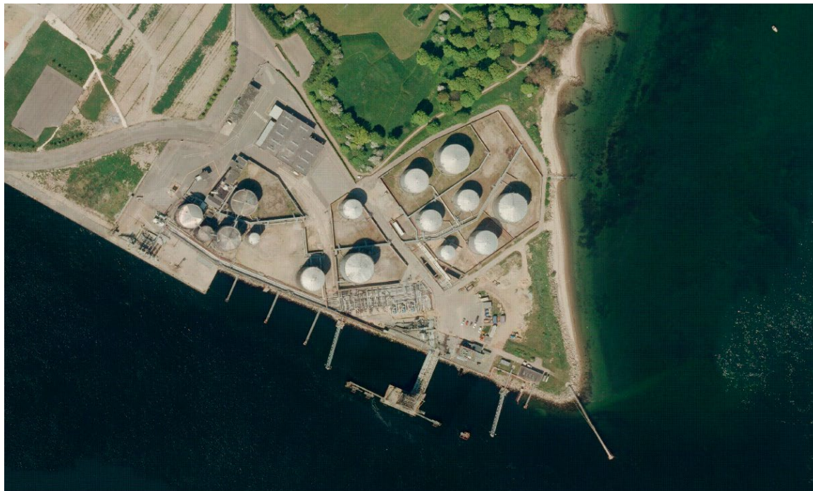
Figur 10. Luffoto over anlægget fra 2012.
