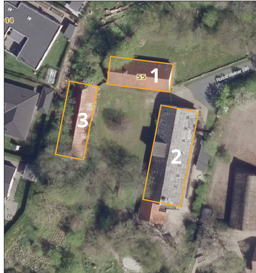
Figur 8 - Bebyggelse registreret som bevaringsværdig. Bygningerne er ombyggede og har en lav bevaringsværdi, hvorfor det kan tillades at nedrive dem.
