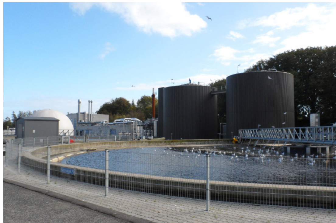
Foto af det eksisterende renseanlæg med bassiner, rådnetårne og andre tekniske anlæg. I baggrunden ses høj, skærmende skovmæssig beplantning.
