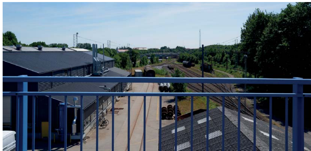
Eksisterende bebyggelse inden for lokalplanområdet, set mod sydøst fra broen ved Vestre Ringvej.
