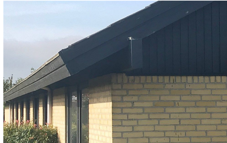
Billede: Eksempel på murrem af træ. Her ført ud over tagkanten i gavlen.
