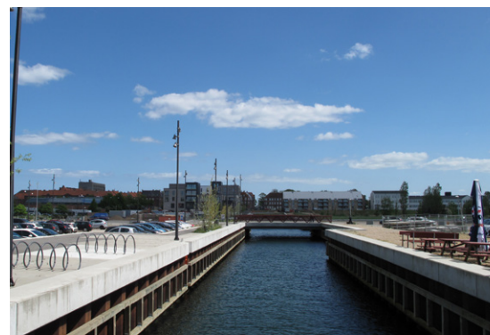
Mod vest grænser lokalplanområdet op til Frederiks Kanal som blev etableret i 2016.
