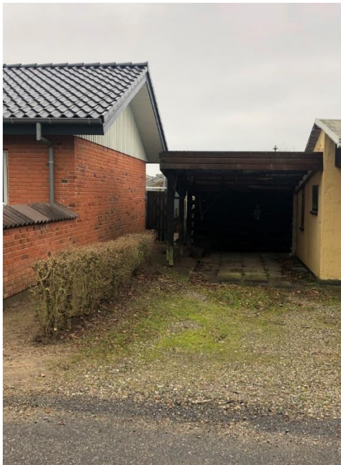
Kærmosevej 25 har Carport i Skel
