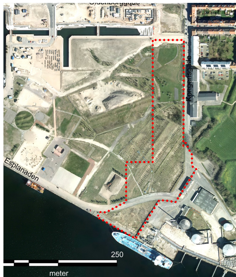
Luftfoto med eksisterende forhold. Frederikshuset er under opførelse nord for Frederiks Kanal. Luftfoto fra 2016.
