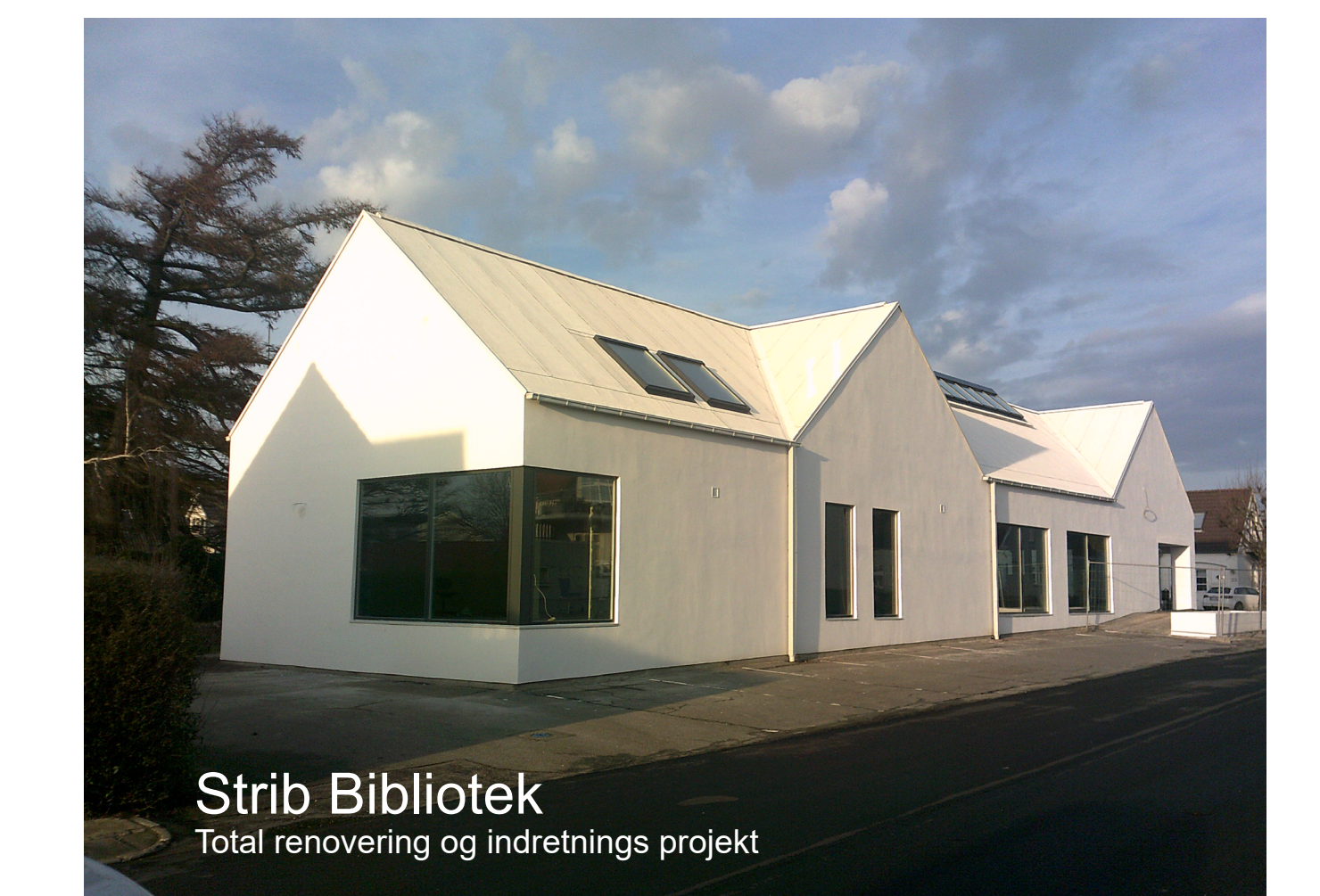
Strib Bibliotek Total renovering og indretnings projekt
