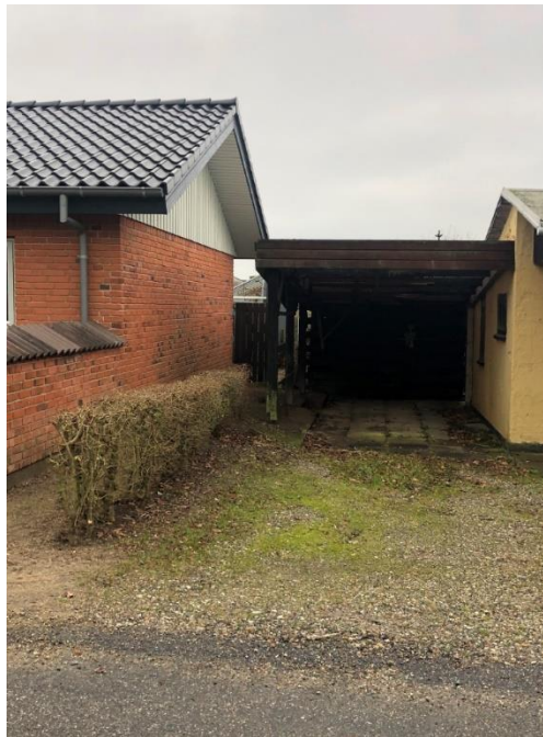
Kærmosevej 25 har Carport i Skel
