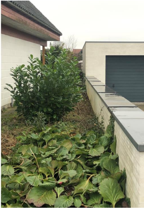
Kærmosevej 27 har garage i Skel, med fald i terræn
