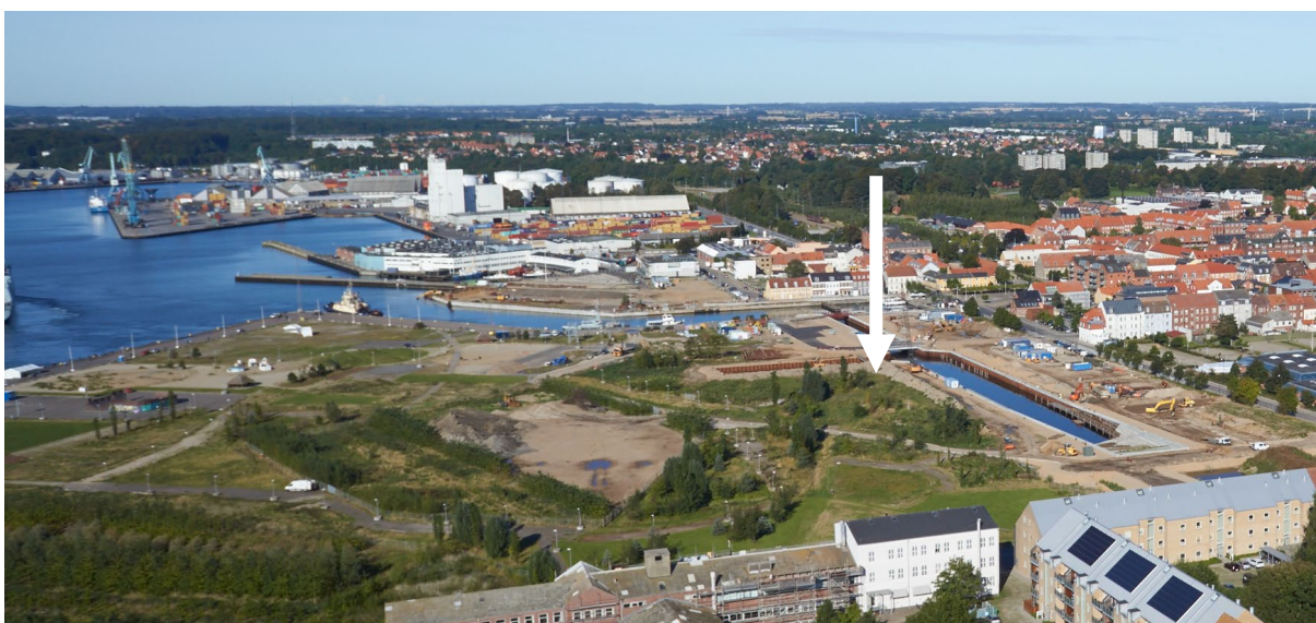
Figur 11: Udsigt over Kanalbyens område fra Kongensgade i retning mod Frederiks Kanal og Oldenborggade. Lokalplanområdet er placeret centralt i billedet (se pil). Lokalplanen viderefører den historiske bystruktur med retlinede nord-sydgående gader. Derved bibeholdes sigtelinjer der er kendetegnende for den historiske bydel. Bag ved det udpegede område ses Gl. Havn der munder ud i havnebassinet/Lillebælt. (Luftfoto fra september 2015).
