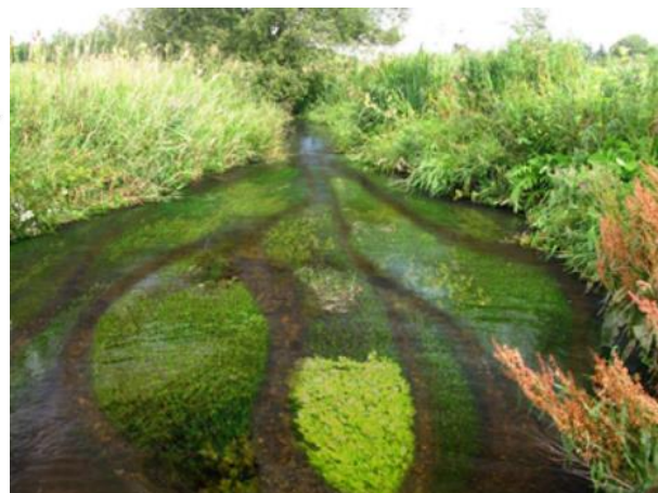
Principskitse og foto af netværksskæring, med grødeskæring i flere små strømrender.
