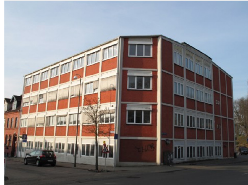
Billede: Før renovering.
