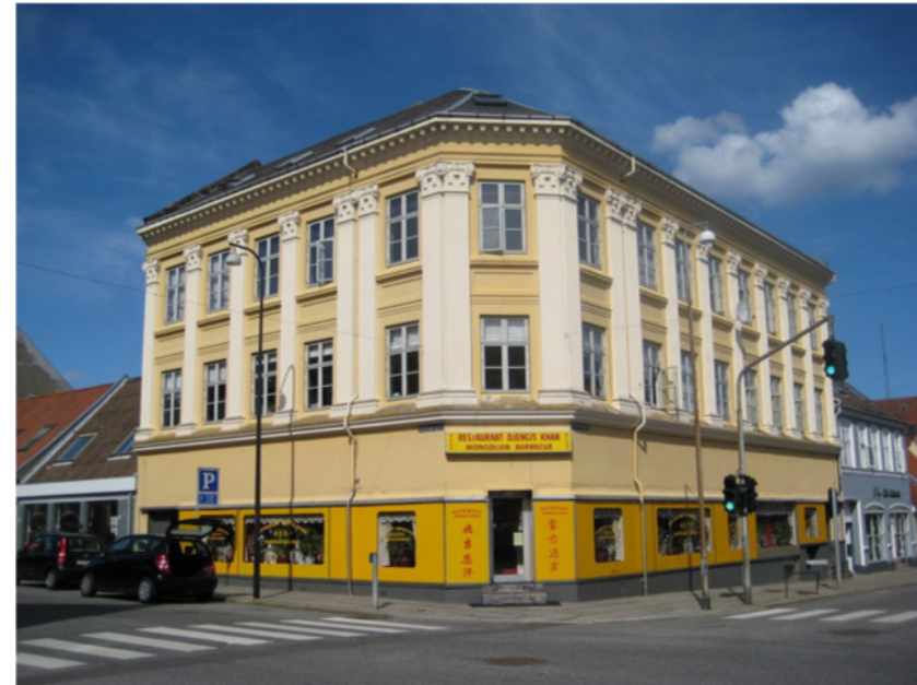
Billede: Før renovering.
