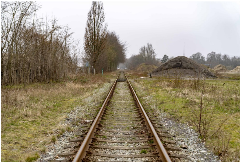
Billede: Eksisterende forhold.
