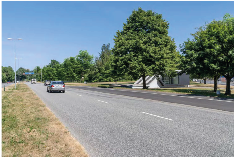
Illustration: Visualisering af støjskærmen set fra Strandvejen - med eller uden beplantning foran. Klik på illustrationen for at forstørre den.
