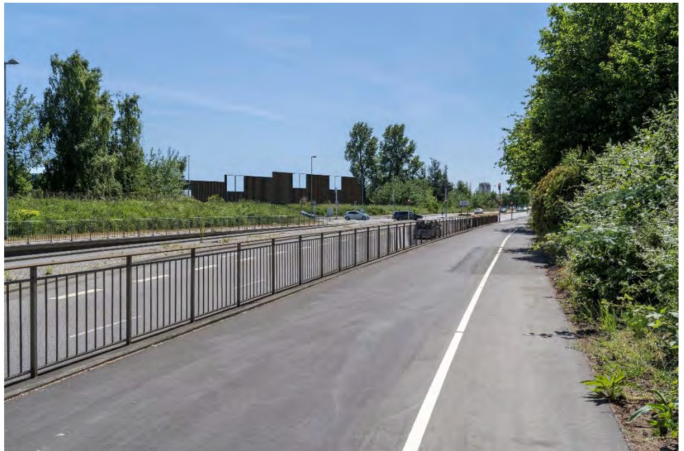
Figur 8-9 Fotostandpunkt 3 med etablering af skærm af træ og partier i glas, uden etablering af punkt træer.
