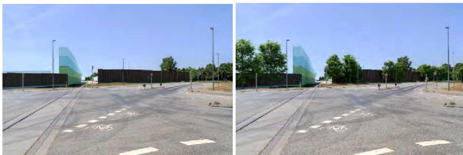
Figur 8-15 og Figur 8-16 Viser fotostandpunkt 4 fra holstensvej med støjafskærmning af træ (til venstre) og støjafskærmning af træ med etablering af enkelt stående træer (til højre). Begge visualiseringer er vist med en mindre jordvold foran skærmen, ud mod Holstensvej.
