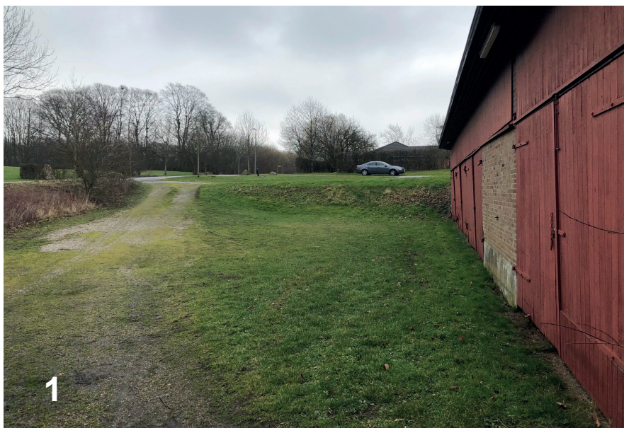
Arealet langs Gl. Færgevej og garagebygning mod Gl. Færgevej
