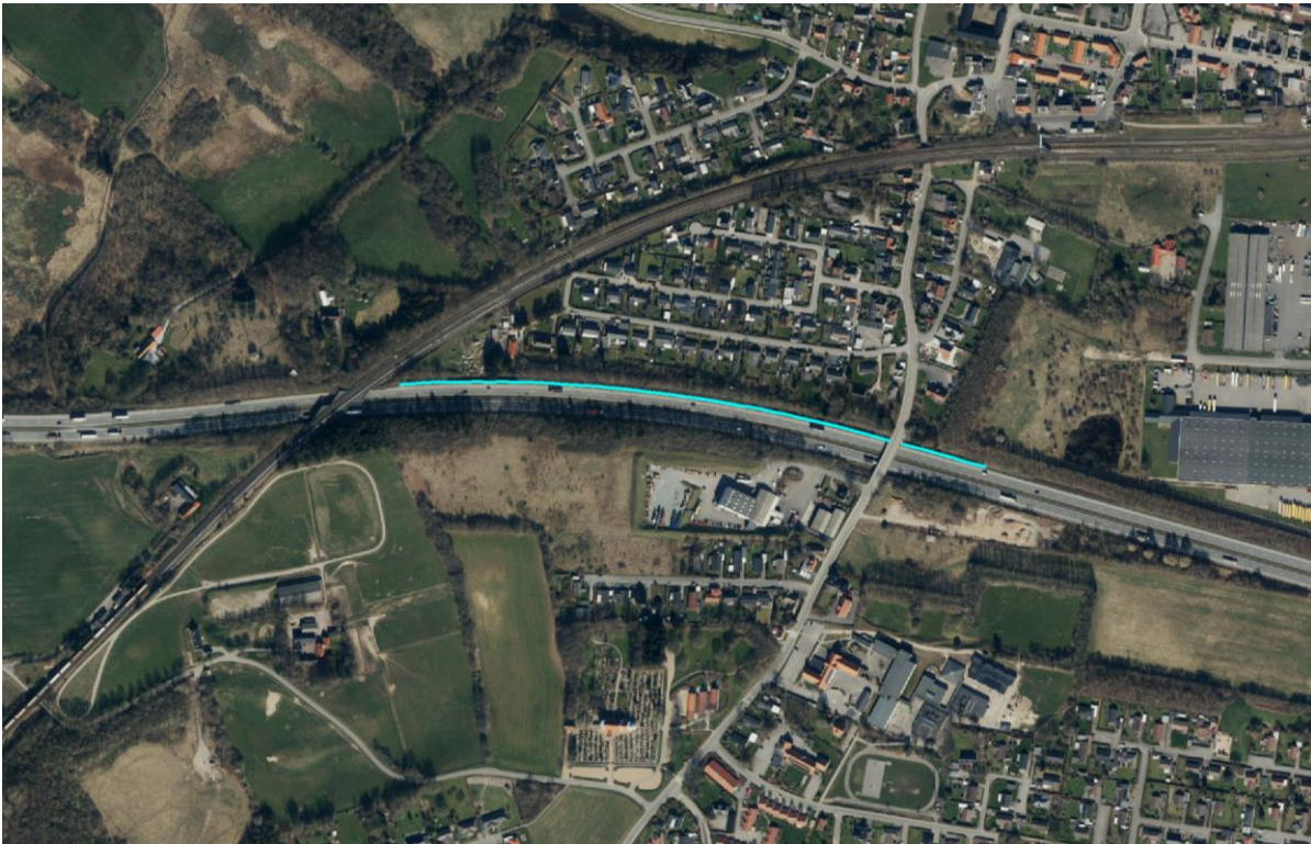
Figur 4.2: Eksisterende støjskærm ved Taulov nord for motorvejen (Vesterled). Skærmen har en højde på 6 meter over vejen.
