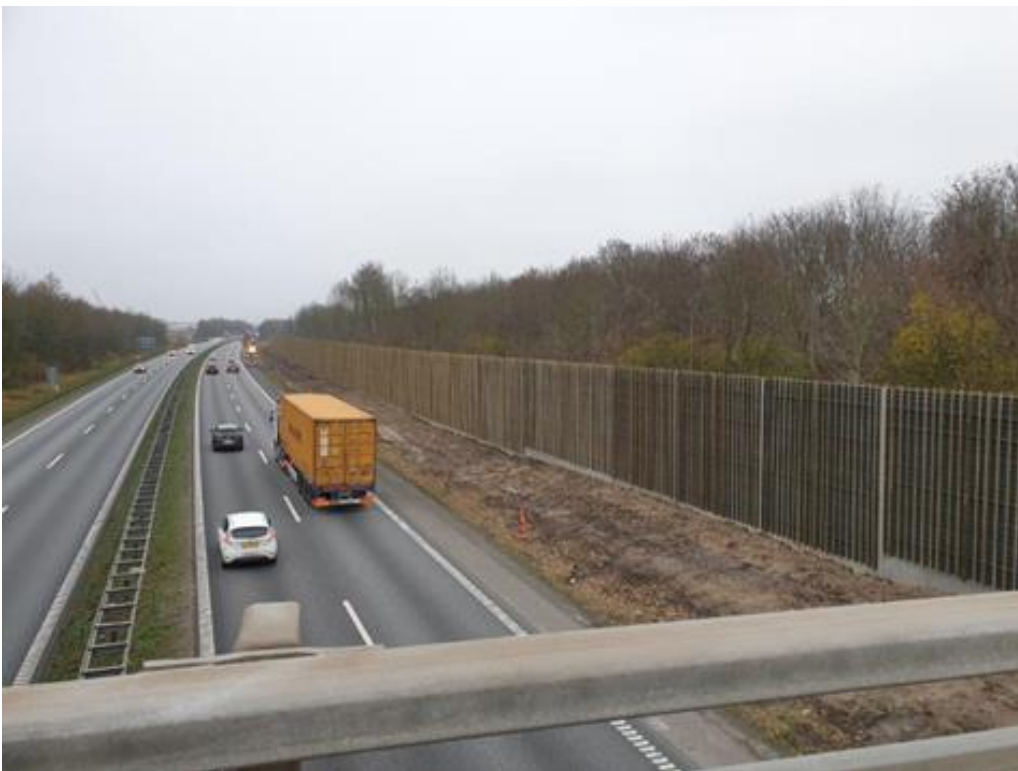
Figur 6.2: Eksempel på støjskærm. Den viste skærm er opstillet langs motorvej E20, og har en højde på 6 meter.
