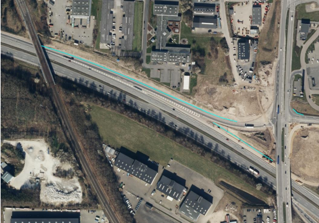
Figur 6.3: Støjskærm ved den vestgående tilkørselsrampe fra Snoghøj Landevej. Skærmen afbrudt, men udført med overlap, så skærmvirkningen ikke forringes.
