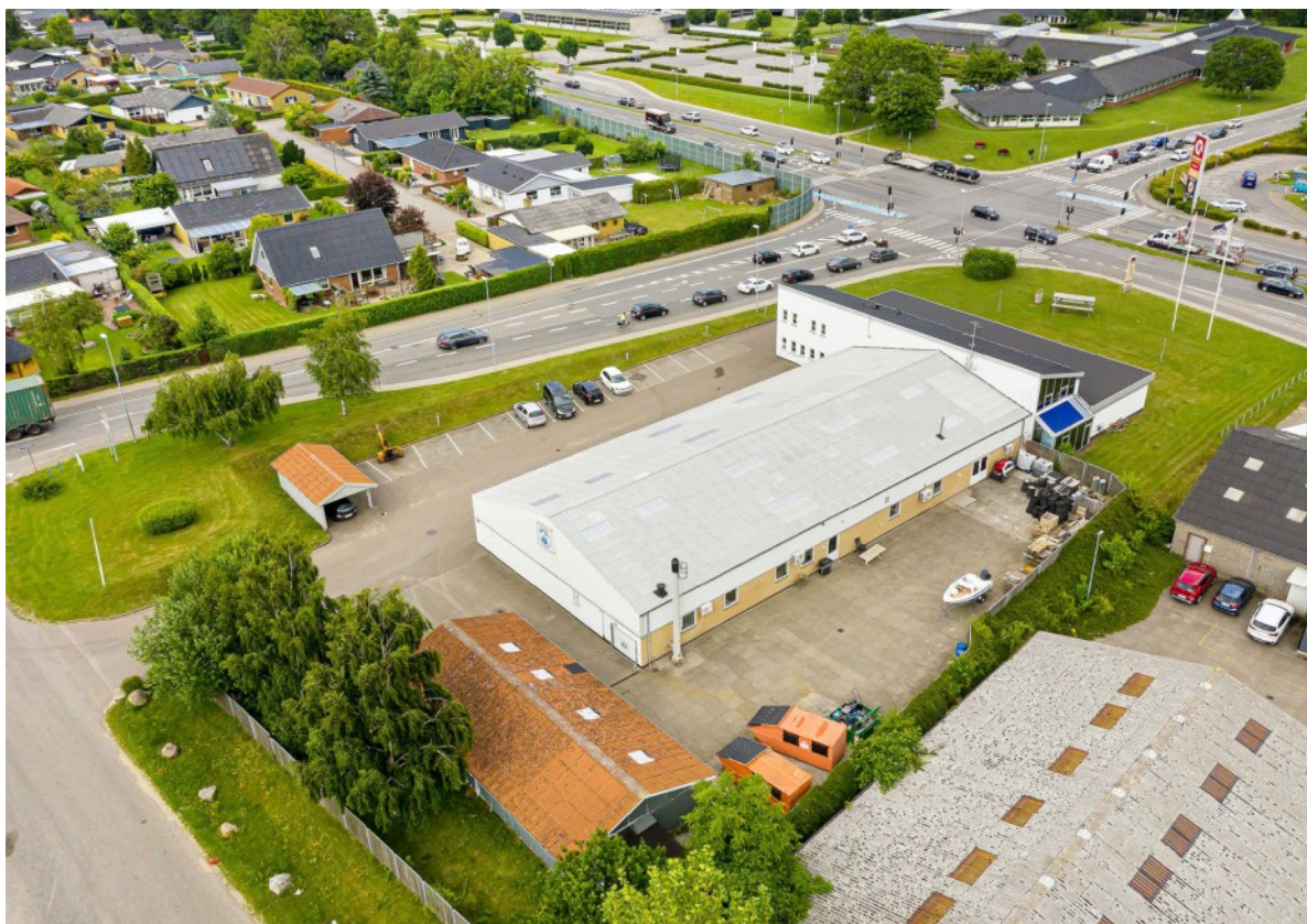
Lokalplanområdet set fra sydøst med de eksisterende bygninger.
