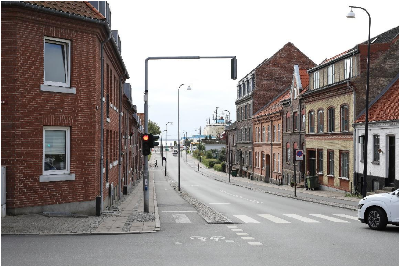
Figur 11.8: Fotostandpunkt 6, eksisterende forhold d. 14. september 2021.
